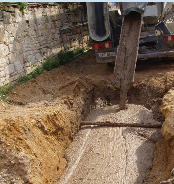
*Flüssigboden – auch als zeitweise fließfähiger, selbstverdichtender Verfüllbaustoff aus Böden und Baustoffen bezeichnet – ist vielseitig verwendbar. Durch seine Fließfähigkeit und hervorragende Selbstverdichtung stellt er eine ausgesprochen wirtschaftliche und sichere Alternative zum konventionellen Einbau von Füllböden dar.*
